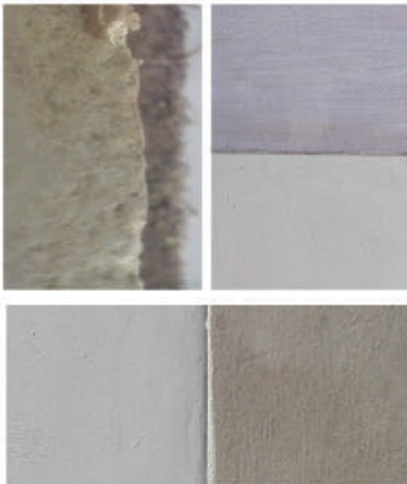
Unión de concreto nuevo con concreto viejo
