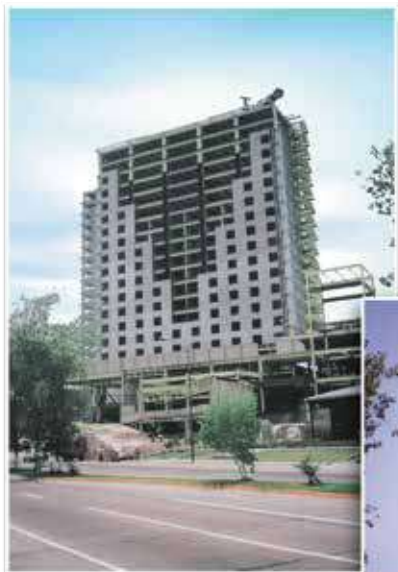
Obra en proceso
