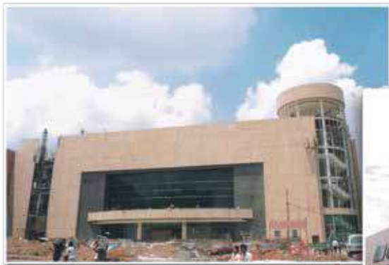
Obra en proceso
