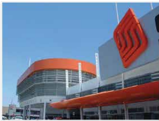
Obra en proceso
