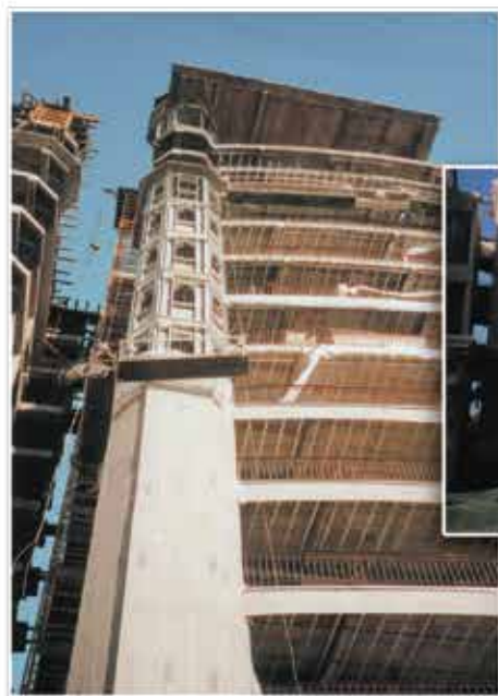
Obra en proceso
