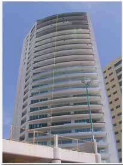
Obra en proceso
