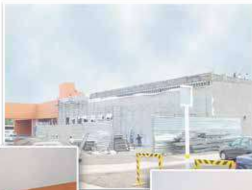
Obra en proceso
