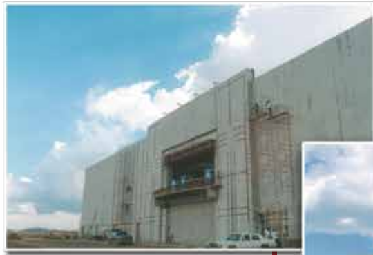
Obra en proceso
