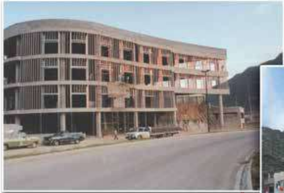
Obra en proceso
