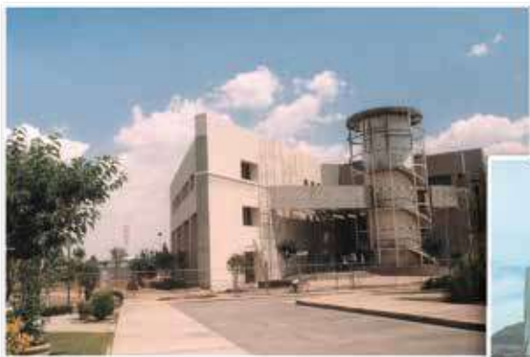
Obra en proceso
