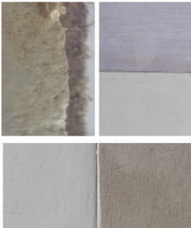
Unión de concreto nuevo con concreto viejo
